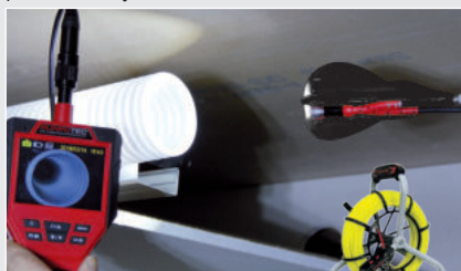
Inspekcija ventilacije i servisiranje
